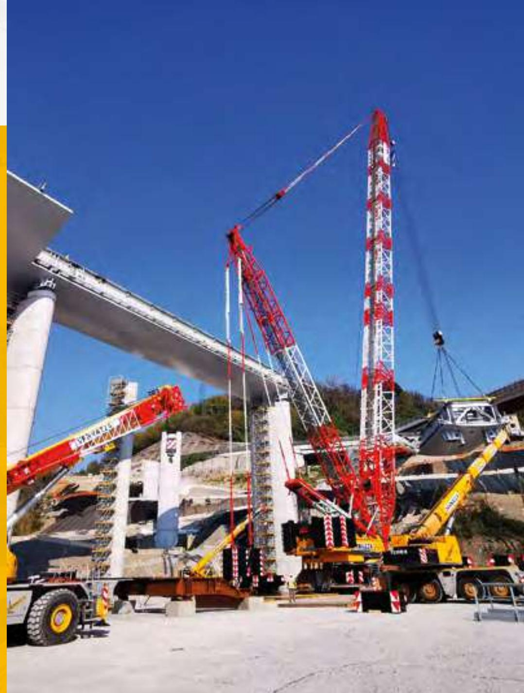
mezzi a turno impiegati nel cantiere, sia gru che piattaforme, dalla portata differente e di diversa altezza. In particolare, un presidio continuativo è stato fornito dalle due gru più importanti in termini di portata: le due Demag CC6800 e CC3800-1.
